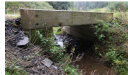
Damit die Fische in die Nebenbäche schwimmen können, werden Rohre unter Straßen durch Brücken ersetzt. Dies nennt man auch Durchgängigkeit der Gewässer. So können verschiedene Fischarten wieder zu ihren Laichplätzen gelangen.
